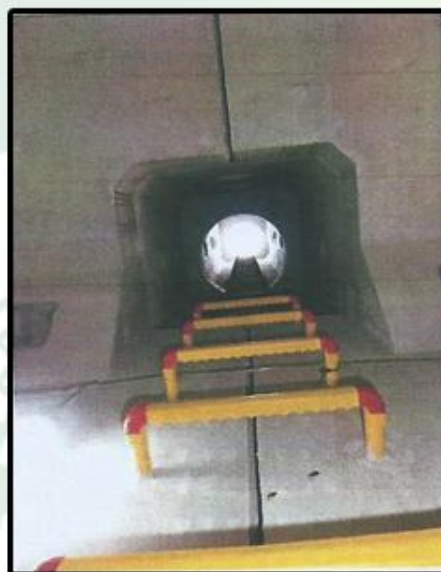
← 檢修口內爬梯
